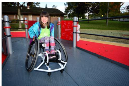
Rampes à double largeur: Permettent d'accueillir les enfants de toutes les habiletés
